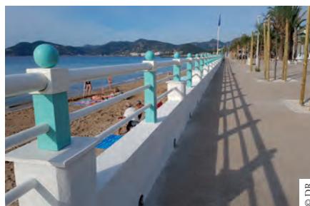
Une réalisation : le garde corps de Bocca Cabana sur le littoral de Cannes.
